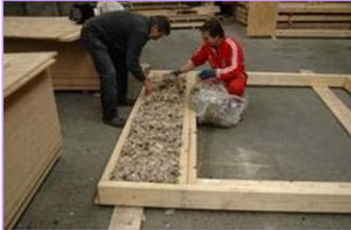
Los productos **RMT-NITA® WOOL** se fabrican con lana de oveja, convenientemente tratada, en formato de mantos y placas termofijadas así como también a granel, con distintas densidades, grosores y capacidades aislantes, permitiendo abrigar eficientemente todo tipo de edificios de obra nueva y rehabilitación.
