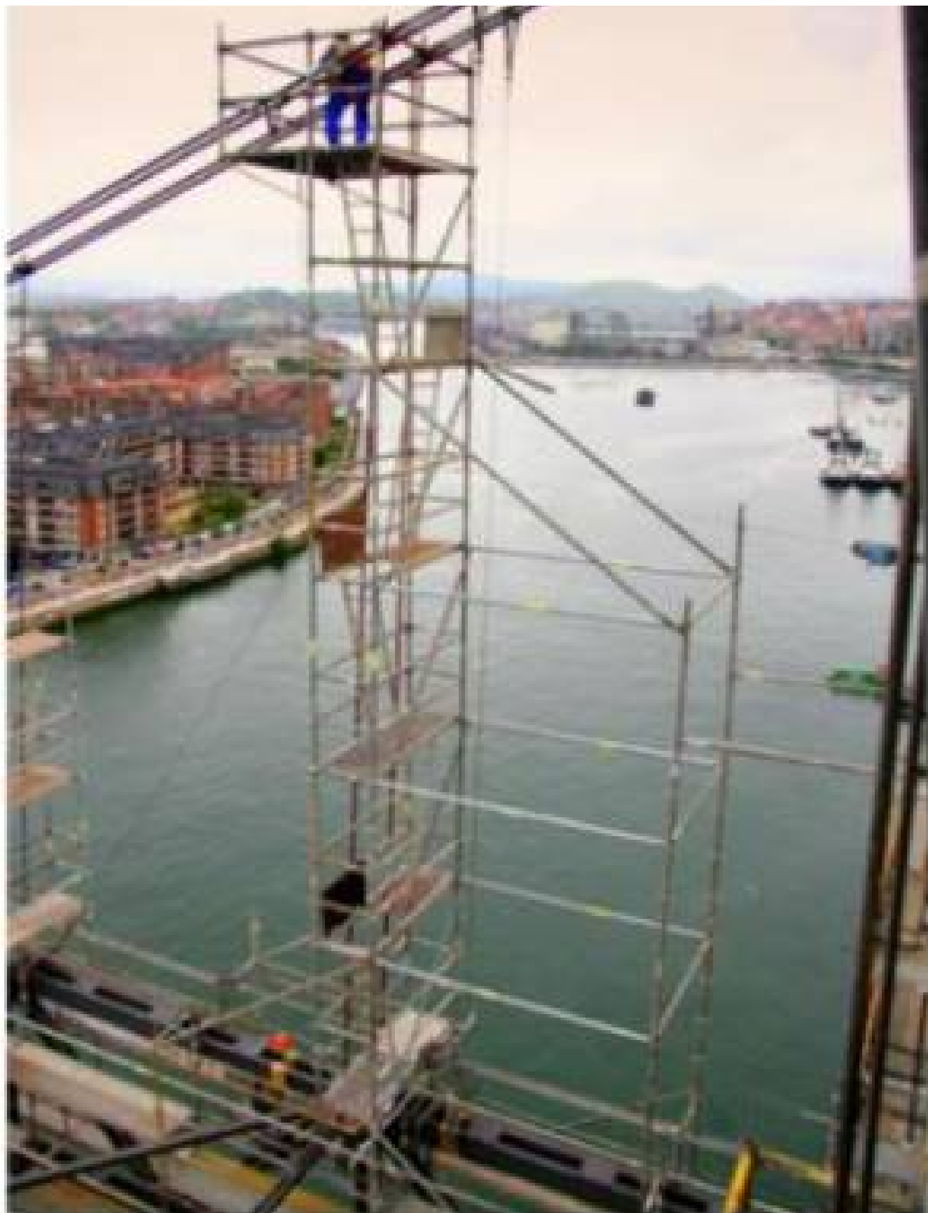
Foto 3: La reposición de un yugo y péndola en los cables principales, exige una escenografía propia de circo
