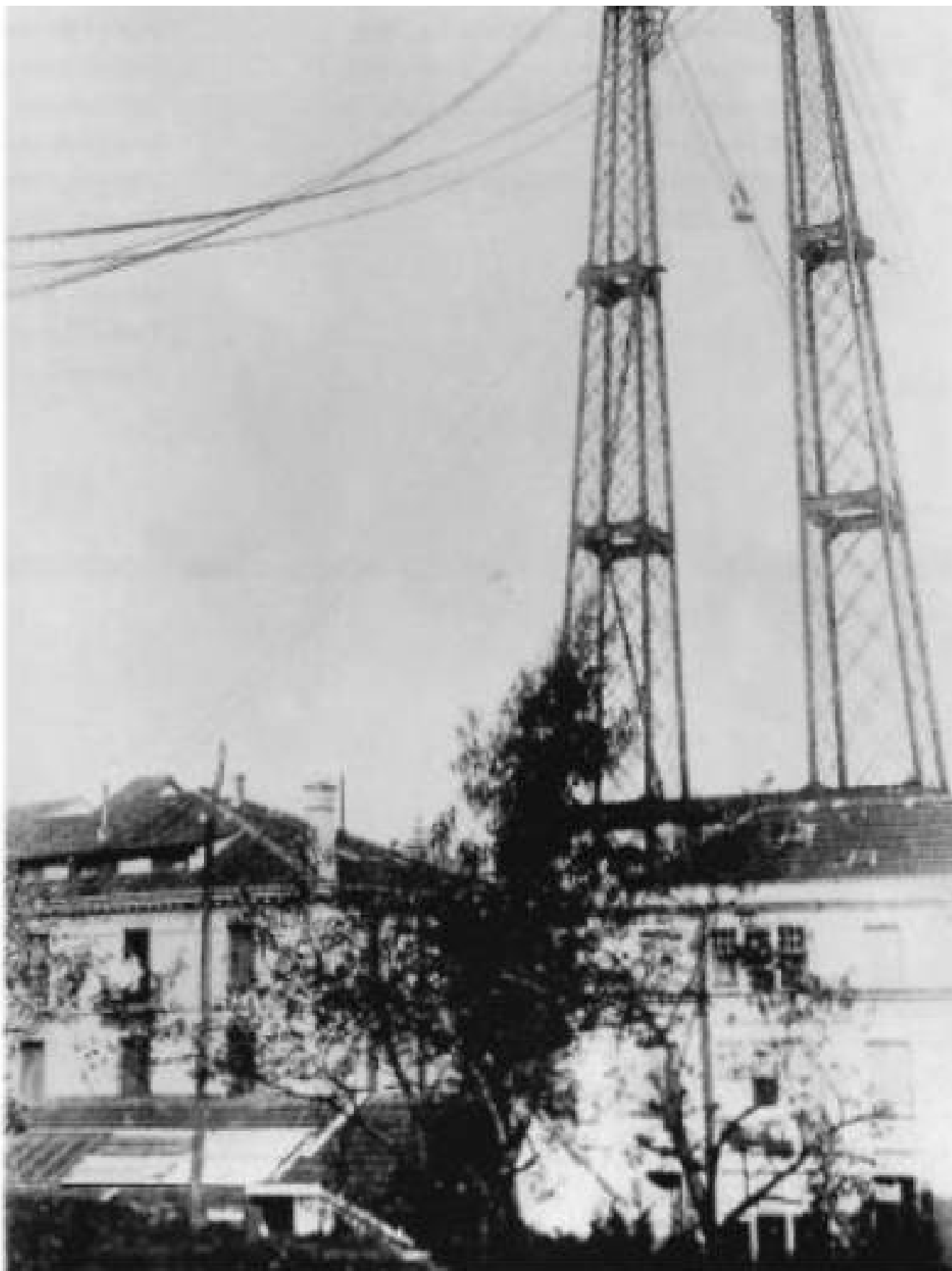
Foto 1: en el verano de 1940, dos obreros trabajan sobre los cables confiados tan sólo en su dominio del riesgo con la misma naturalidad que lo haría el propio Nick Wallenda
