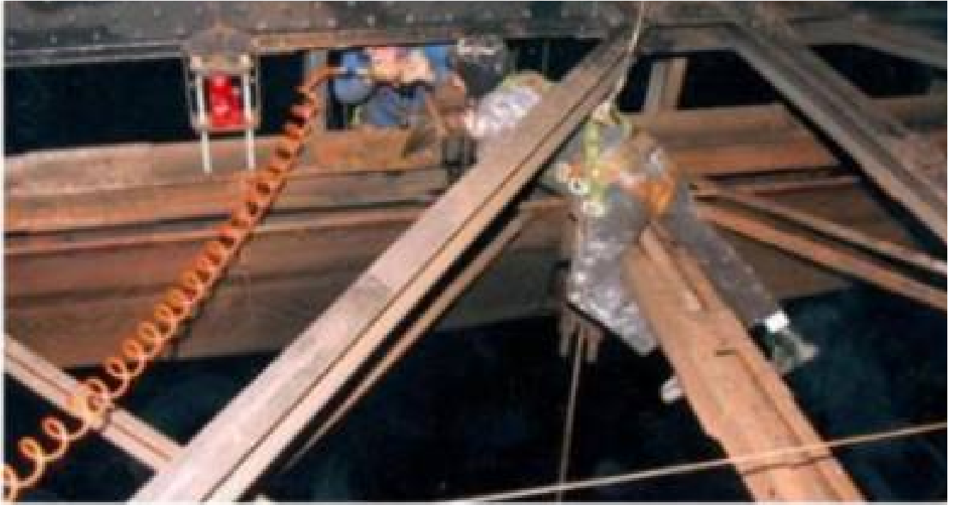
Foto 2: en la foto superior: oficial y ayudante en un trabajo con nocturnidad y altura en la primavera de 1996, ultiman el cambio de una rueda del viejo carro, sujetos por las líneas de vida recién instaladas.
